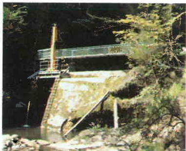
Gemauertes Stauwehr, erstellt 1867
