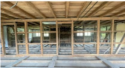
Hinter den Verkleidungen sind diverse Überraschungen zum Vorschein gekommen... Dazu zählt ein lange zurückliegender Wasserschaden, welcher bedingte, dass der einsturzgefährdete Holzboden im Dachgeschoss ersetzt werden musste.
