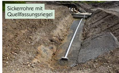
In der letzten Etappe wurde eine neue Quelfassung mit zwei Quellsträngen errichtet, welche das austretende Wasser sammeln. Das Auslaufrohr führt durch einen doppelten Betonriegel und wird mit gründlich gewaschenem Geröll abgedeckt, so dass die Oberfläche anschliessend renaturiert werden kann.
