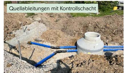
an den bestehenden Quellschacht angeschlossen. So konnte das frisch gefasste Quellwasser nach Freigabe der Trinkwasserprobe ins Trinkwassernetz eingeleitet werden.
