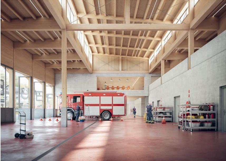
Beim Feuerwehrdepot sollen statische bzw. architektonische Elemente wie Büge und Stützen einen Bezug zu diesen Bauten schaffen. Die Einstellhalle wird durch zwei Fachwerkträger in der Längsrichtung überspannt, diese bilden gleichzeitig das Oblicht und sorgen für eine rückwärtige Belichtung. Grundsätzlich werden rohe Materialien eingesetzt. Die verschiedenen Materialien sollen dort eingesetzt werden, wo sie am effizientesten sind.
