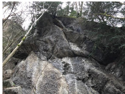
Bild 2: Abbruchstelle oberhalb Fussweg
