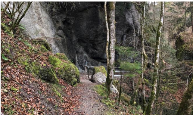
Bild 1: Fussweg mit abgebrochenem Felsblock
