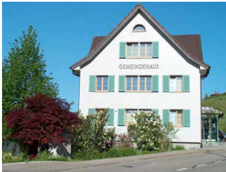
Ehemaliges Gemeindehaus Goldingen
